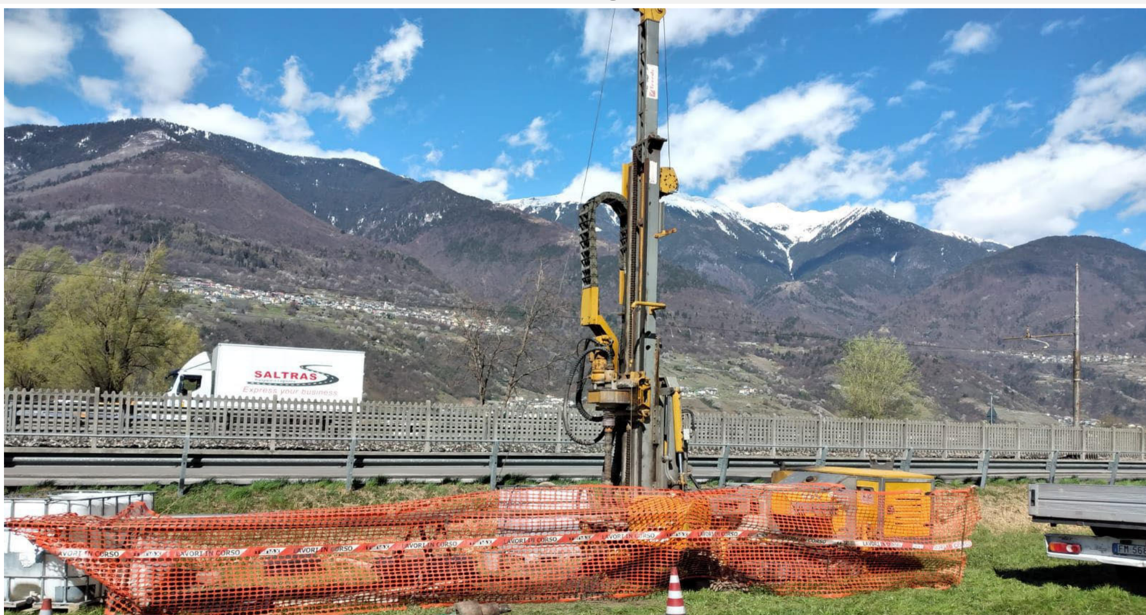
Postazione SONDAGGIO S1-DH
